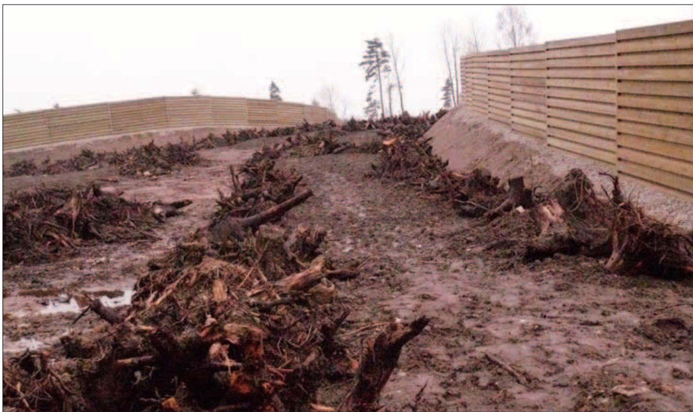
Praegu pole ökoduktil palju vaadata. Ka on ligipääs raskendatud pehme maapinna ja okste tõttu. Pori tõttu on praegu ökodukti ebamugav kasutada ka loomadel. Kohalikud on loomi objekti juures siiski silmanud. RIHO PARAMONOV
